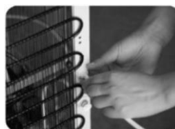
tilslut PE -røret til indgangsforbindelse
